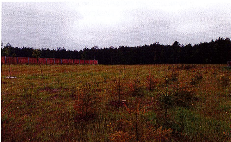
Fot. 8 Górne przejście dla zwierząt dużych km 380+600
