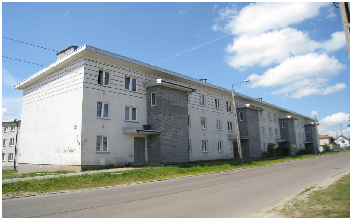
Budynek z lokalami socjalnymi w Białymstoku (ul. Dojnowska)
