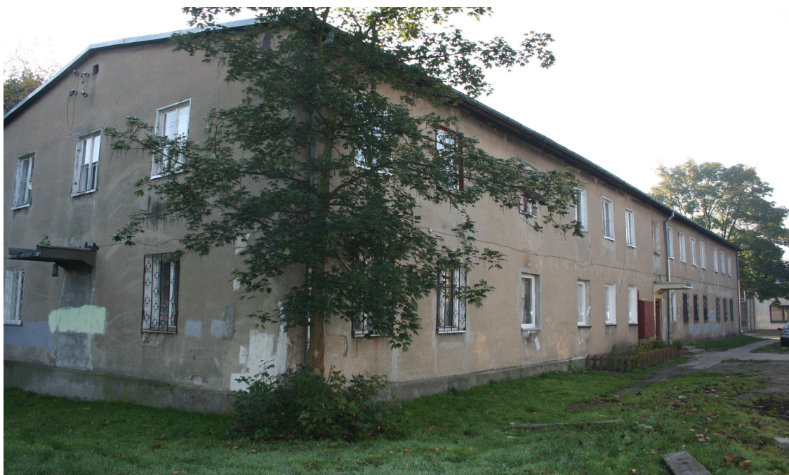
Budynek z lokalami socjalnymi w Łodzi (ul. Helska)
