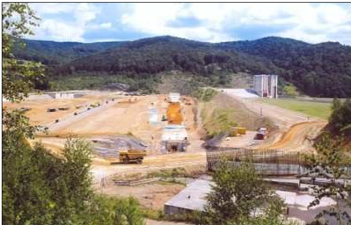
Rozpoczęcie budowy korpusu zapory - 2004 r.
