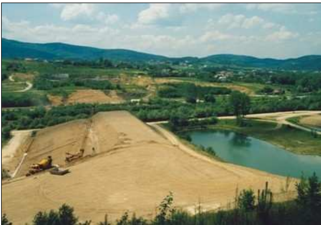
Rozpoczęcie budowy korpusu zapory - 2004 r.
