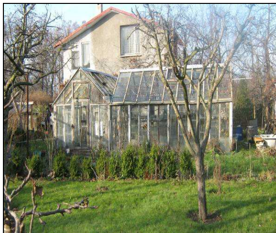
Foto 8. Obiekt wybudowany na terenie rod „Przyszłość”
