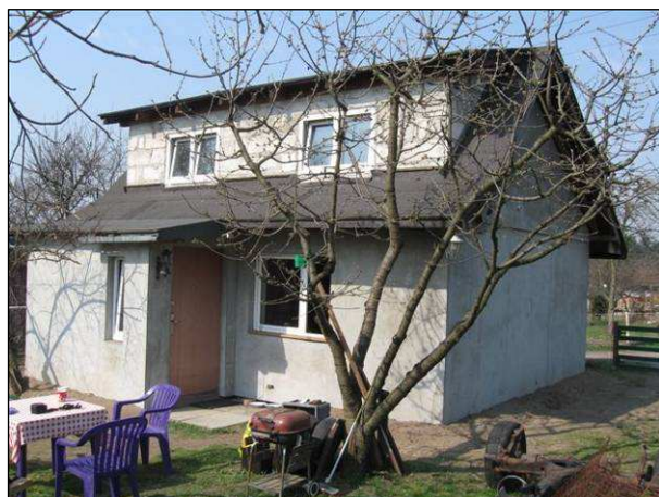
Foto 14. Obiekt wybudowany na terenie rod, funkcjonującym na obszarze miasta Poznania
