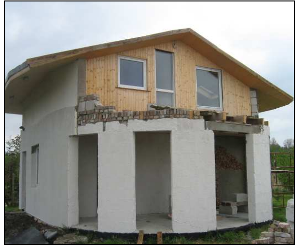
Foto 17. Obiekt wybudowany na terenie rod „Nad Zalewem”
