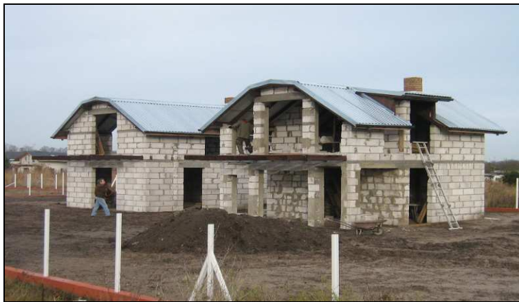
Foto 18. Obiekt wybudowany na terenie rod „Nad Zalewem”
