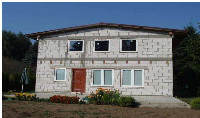
Foto 11. Obiekt wybudowany na terenie rod „Na Zakolu”
