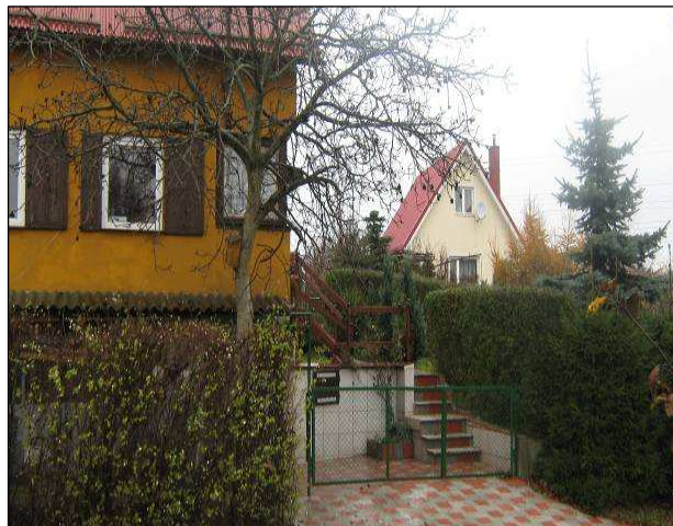
Foto 7. Obiekt wybudowany na terenie rod „Komunalnik”
