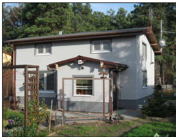
Foto 15. Obiekt wybudowany na terenie rod funkcjonującym na obszarze miasta Poznania
