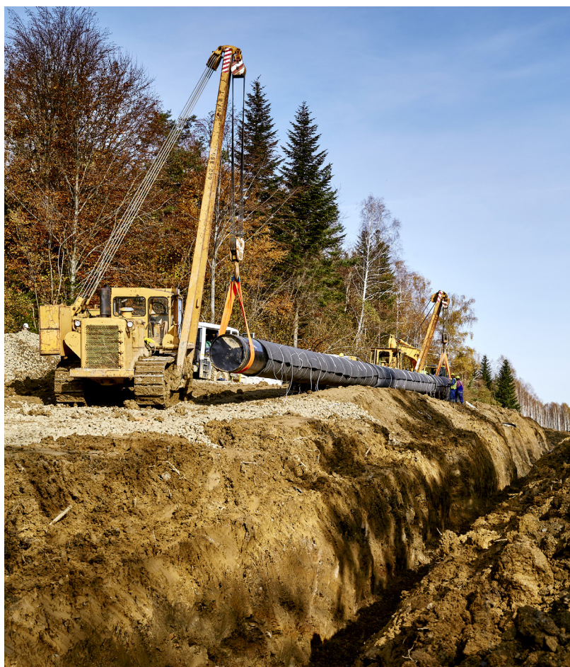
Zdjęcie nr 1 Budowa gazociągu Polska–Słowacja
