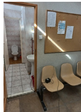
Zdjęcie nr 11 Zastępcze podłączenie bramki do wykrywania metali
