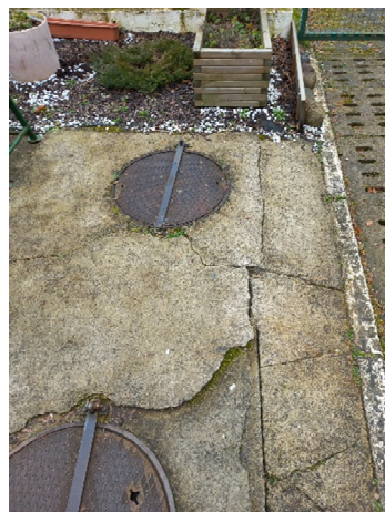
Zdjęcie nr 5 ZP w Gdańsku Oliwie – zabezpieczenie studzienek
