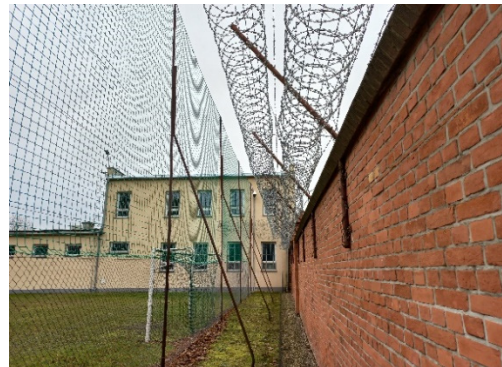
Zdjęcie nr 2 SdN w Chojnicach – linia zewnętrzna ogrodzenia z podwójnym zwojem concertiny i kamerą kopułkową
