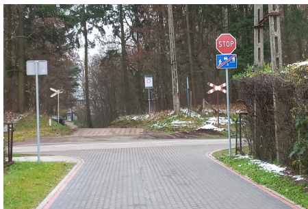
gm. Stegna – przebudowana droga gminna w sołectwie Jantar Leśniczówka
