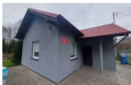
gm. Bobowo – tynk strukturalny na elewacji i oświetlenie świetlicy wiejskiej w Grabowcu
